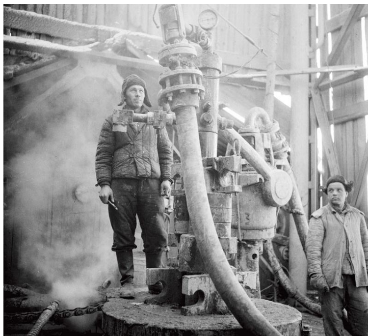
Цементирование скважины внутри буровой. Ухтинский район. 1952 г.
