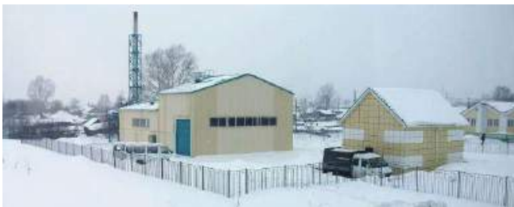
Рисунок 1 – Общий вид котельной
