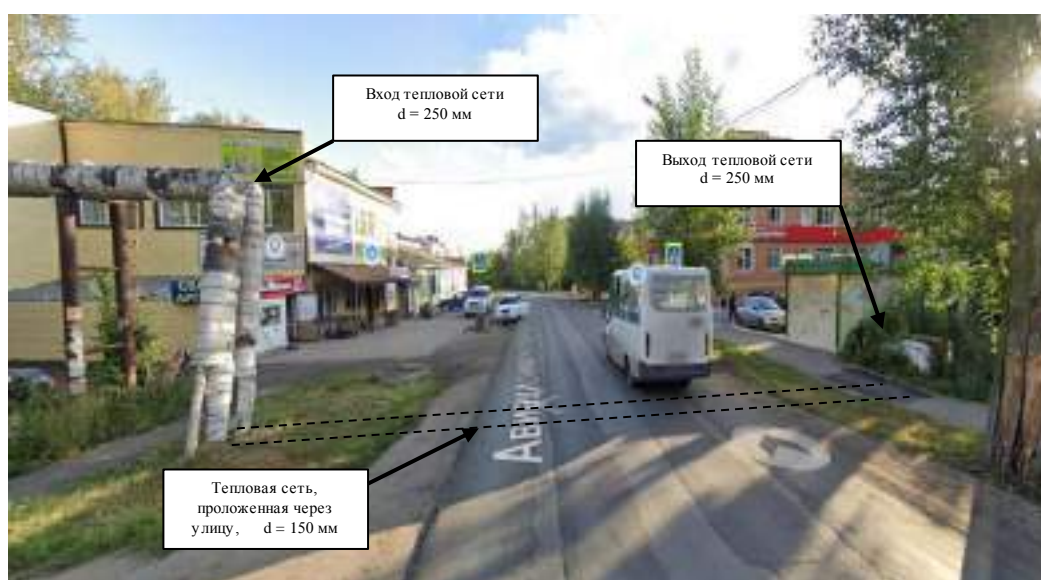
Рисунок 2 – Часть тепловой сети, проходящая через Авиационную улицу: а – изображение на карте, б – реальное изображение участка
