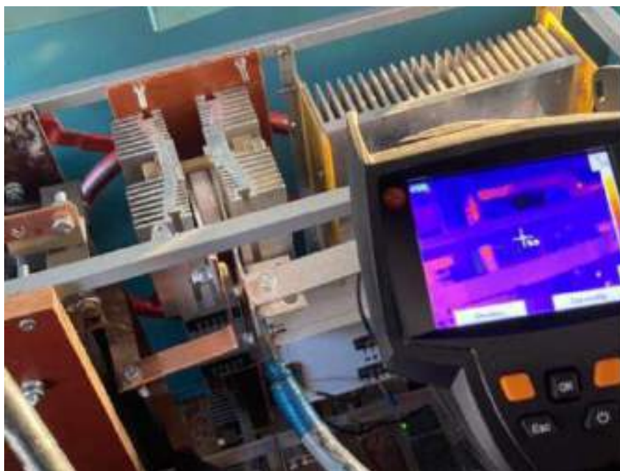
Рисунок 6 – Тепловизионный контроль технического устройства
